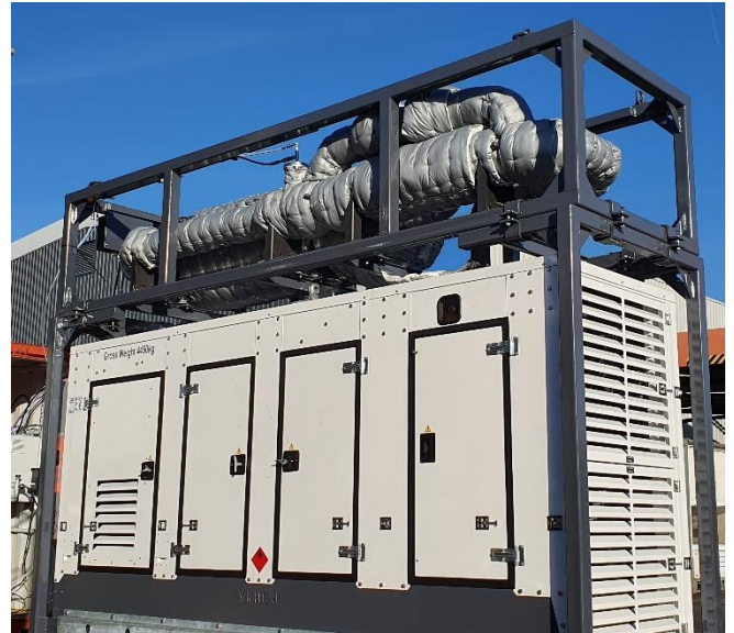
Foto: 125 kVA genset met Discom Stage 5 frame
